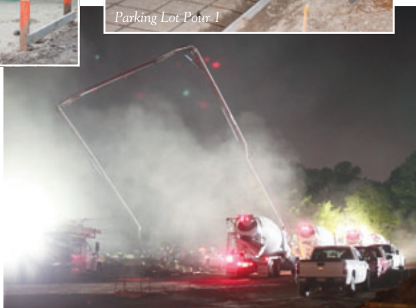
Parking Lot Pour 2
